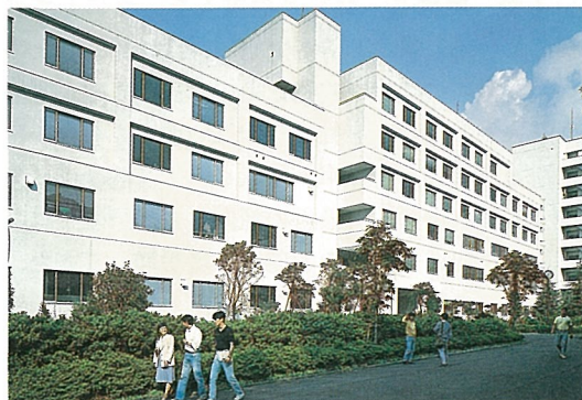
生産工学科研究棟
