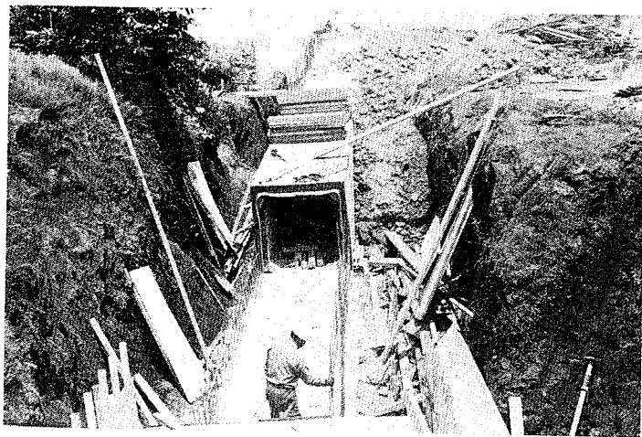
共同溝建設現場
