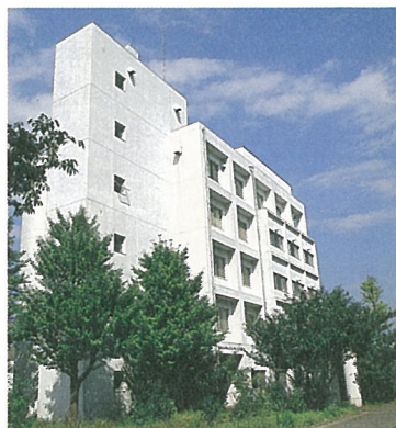
エ ネ ル ギ ー 工 学 棟
