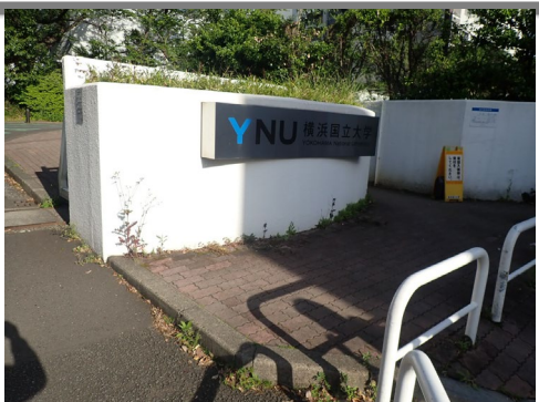
植込撤去 サイン移設
